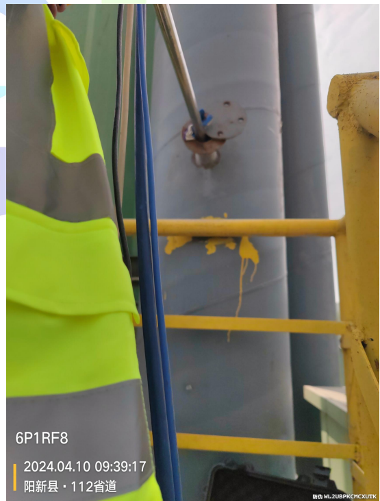
6P1-BF8 码头出库输送皮带排气筒采样口◎15
