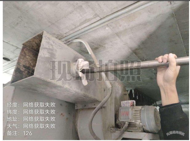
隧道出口陆域熟料库底输送皮带(水泥) DA126 有组织排放废气检测点位
