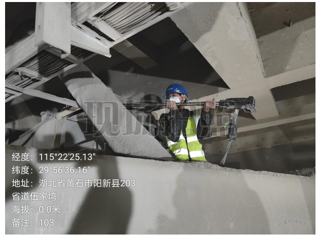
水泥库底 3 输送 DA103 有组织排放废气检测点位
