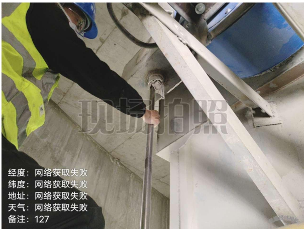
排气筒 DA127 隧道出口陆域熟料库底输送皮带(水泥) 有组织排放废气检测点位
