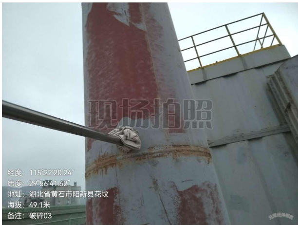
石灰石破碎机 DA003 有组织排放废气检测点位
