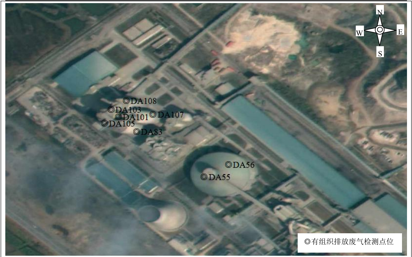
附图：现场检测照片
