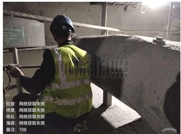
水泥库底 DA108 有组织排放废气检测点位
